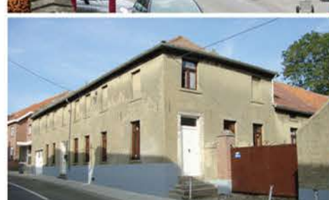
Bergstraat: afbraak historische hoeve en ruïne Hof van Bierbeek wachtend op de opstart appartementsbouw.
